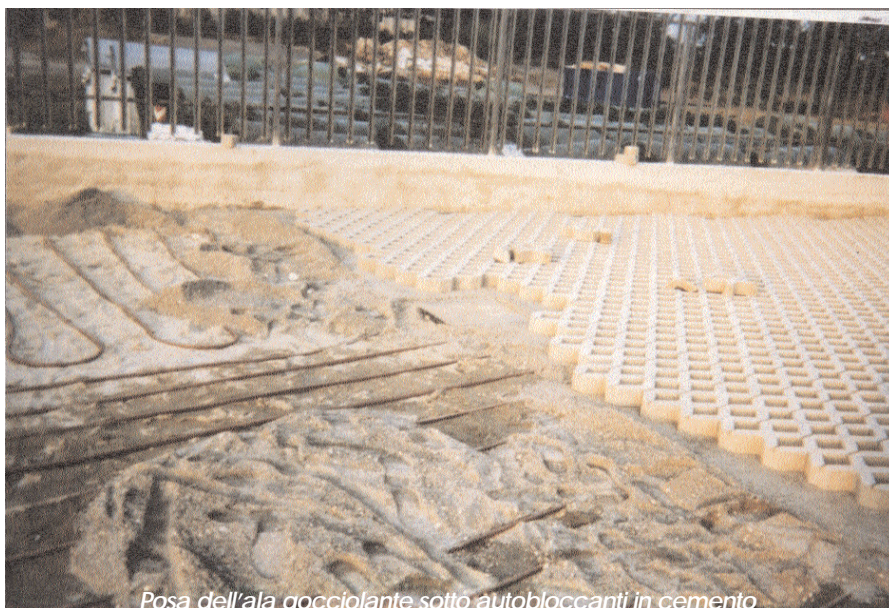
Posa dell'ala gocciolante sotto autobloccanti in cemento
