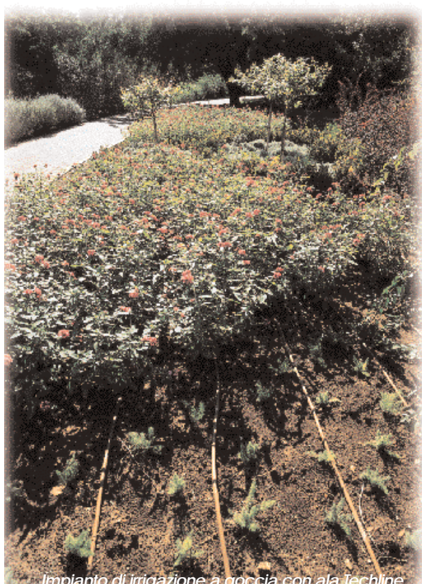
Impianto di irrigazione a goccia con ala Techline
