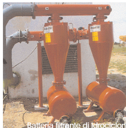
Batteria filtrante di Idrocycloni
