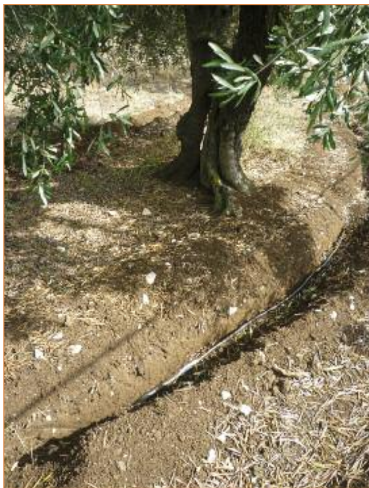
INSTALLAZIONE DELLA SUBIRRIGAZIONE SU OLIVETO PRODUTTIVO
