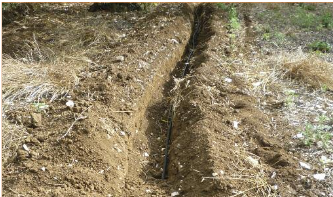
PREPARAZIONE DEL TERRENO PER INSTALLAZIONE IN SUBIRRIGAZIONE
