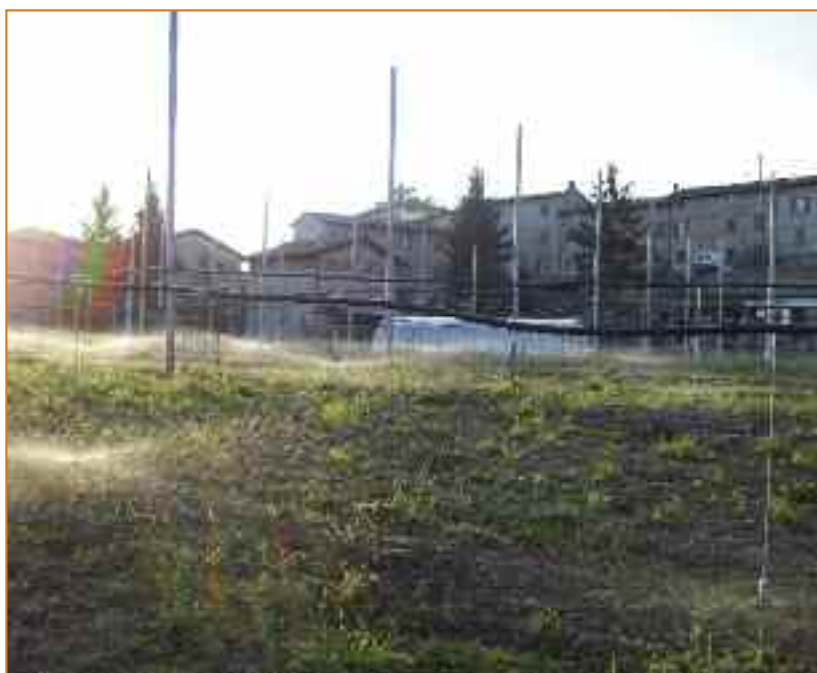
IMPIANTO DI IRRIGAZIONE IN FUNZIONE
